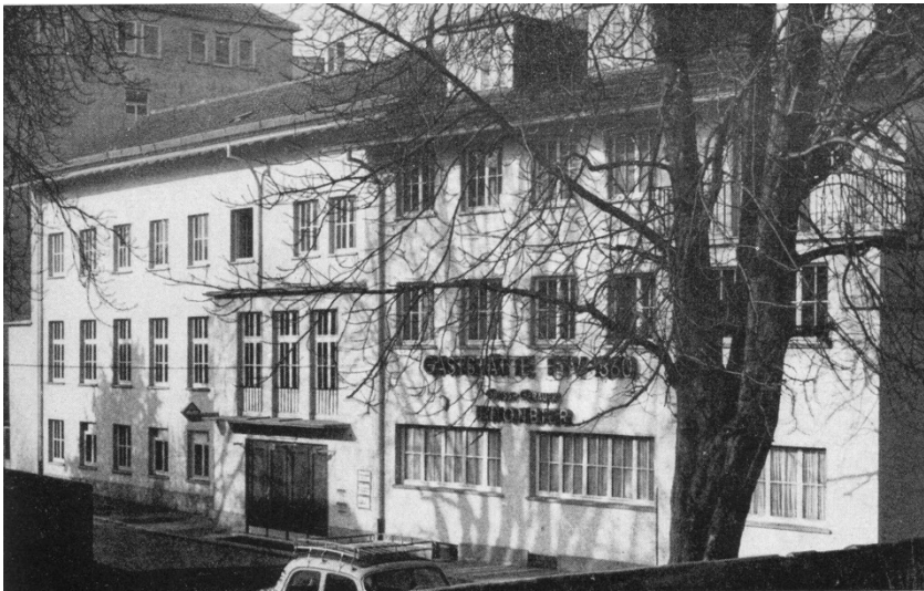
Photo: Gebäude nach dem Wiederaufbau in den 1950er Jahren
